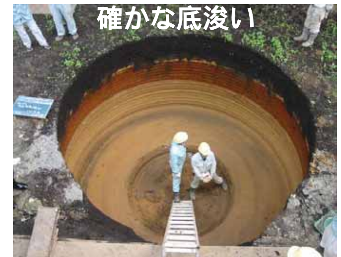
浅層掘削後の状況 4700
